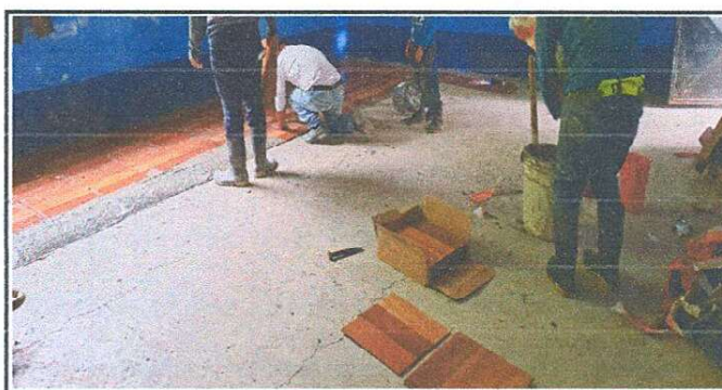
Foto 6: Cambio de piso de torta de cemento a piso cerámico.
