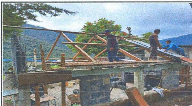
Foto 2: Momento cuando se procedió a quitar el techo antiguo, láminas y reglas respectivamente.
