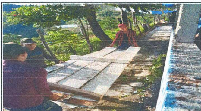
Foto1: Momento cuando se procedió a quitar las cuatro paredes de madera y reglas.
