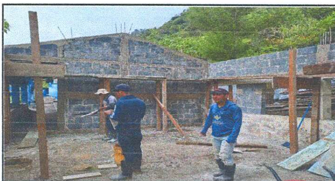
Foto 5: Reparación de repello y cernido con monocapa las cuatro cimentaciones de block ya construido y las paredes respectivamente.
