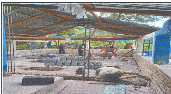
Foto 4: Levantado de pared de block.
